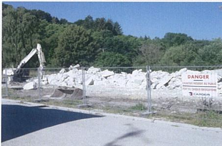
**SOCIAUX** . Concassage des blocs béton subsistants et arasage du terrain pour remise en herbe. La commune procède pour sa part au nettoyage des jardins et à l'ensemencement en gazon après nivelage.
